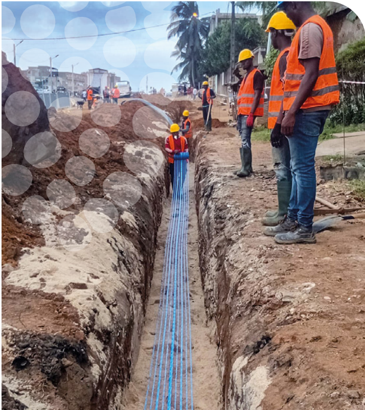
Pose de canalisations à Abidjan
