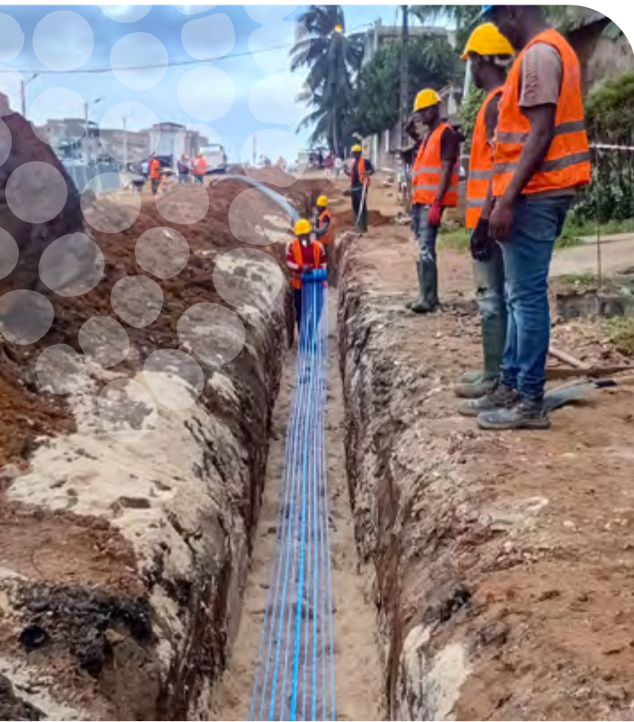
Pose de canalisations à Abidjan
