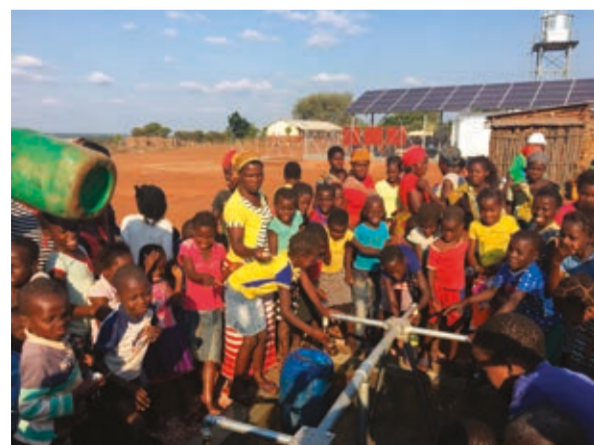
Les 600 habitants du village de Manhica tirent les premiers litres d'eau d'un système d'approvisionnement en eau potable par énergie solaire mis en place par VERGNET HYDRO et AFRIDEV MATI, avec systèmes de dessalement solaire OSMOSUN®.
