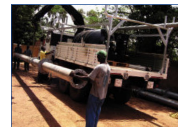
Déchargement d'un réservoir sur mât.
