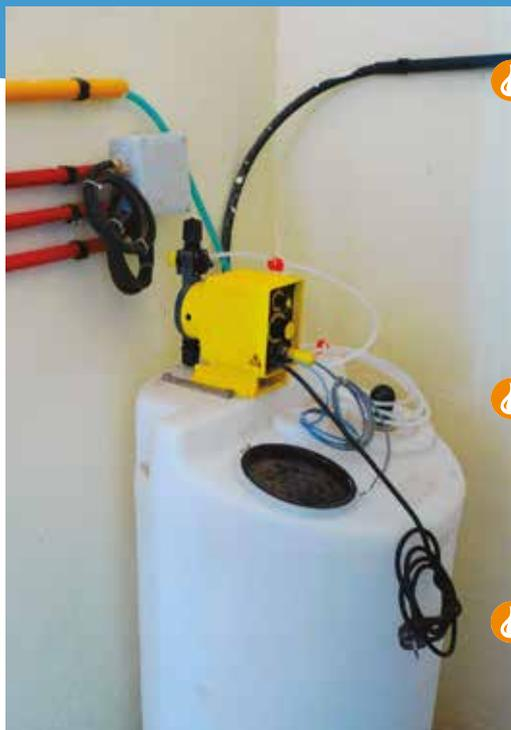
Système de dosage et d'injection électriques de chlore.
