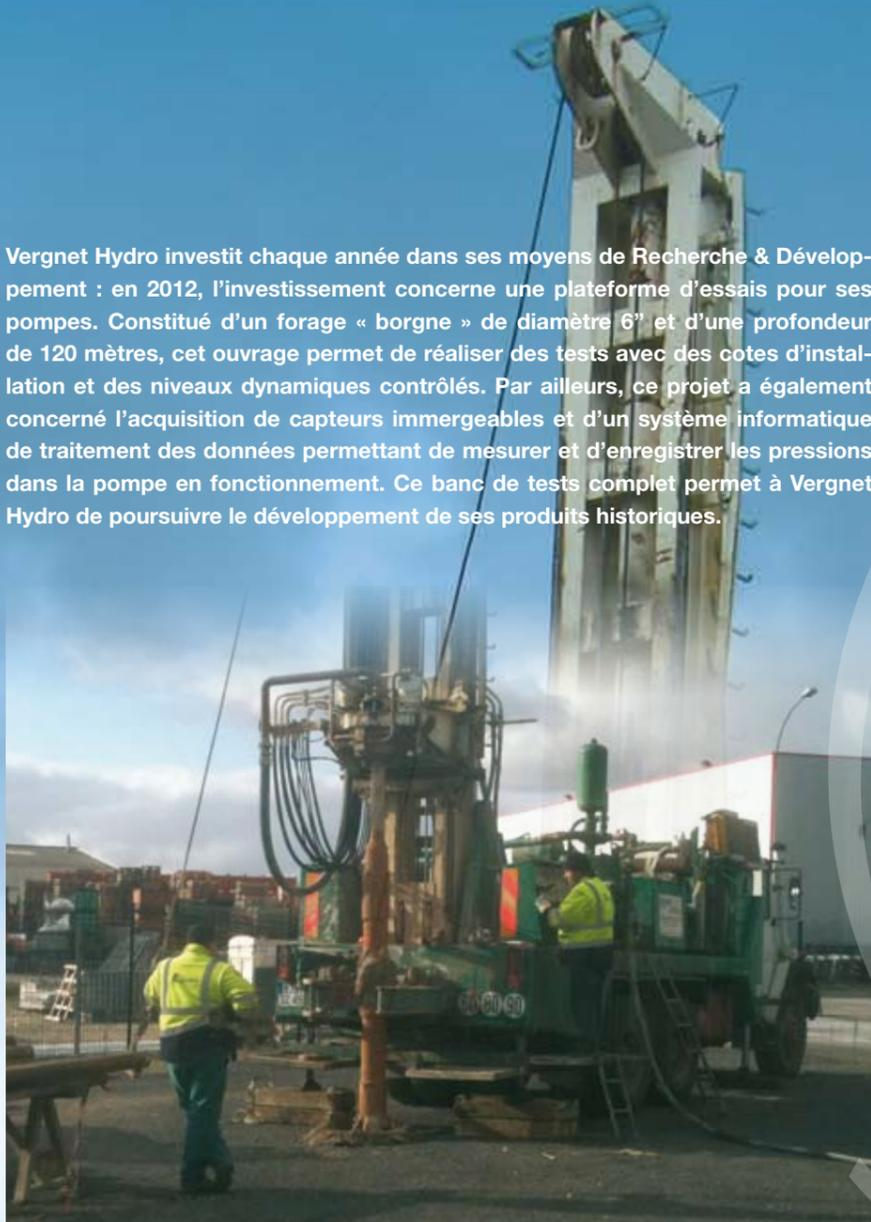
forage « borgne » de diamètre 6" et d'une profondeur de 120 mètres
