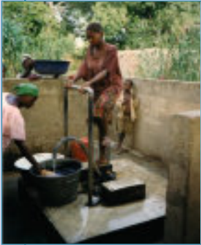
Équipement multiple sur le même forage
